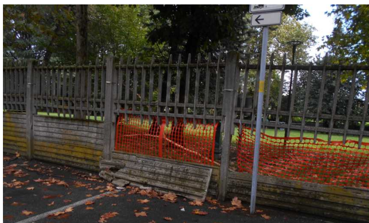
Foto 1: Recinzione da demolire
