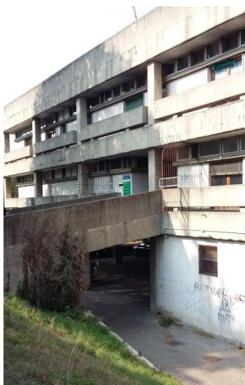
Foto 1: Accesso anteriore al piano terra
