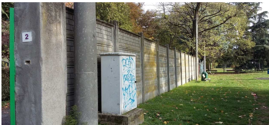
Foto recinzione da demolire
