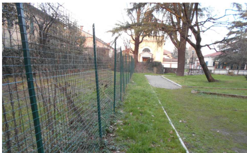
Foto 1: Recinzione esistente da rimuovere
