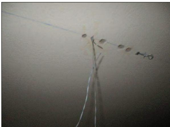
Foto n°3 - Dettaglio del fissaggio del tassello al solaio sovrastante, che avviene in corrispondenza del travetto.
