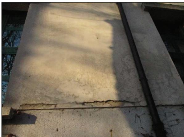
Foto n°29 - Porzione del rivestimento ampiamente distaccata, individuata sul fronte Sud a livello del Bagno 4 al piano rialzato.
