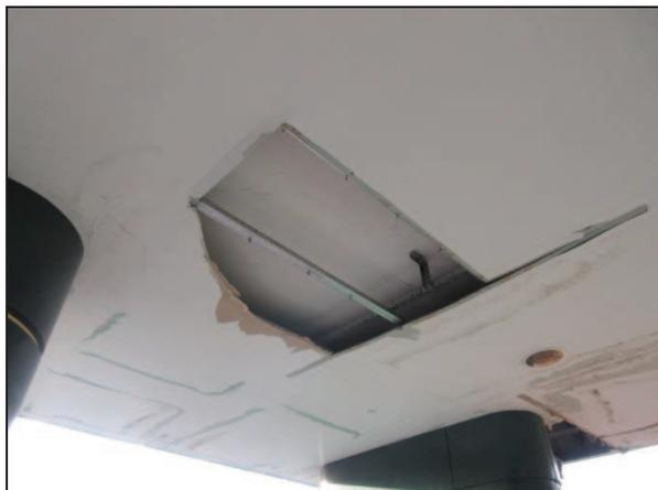
Foto n°9 - Vista di una porzione di controsoffitto in cartongesso degradata a causa delle infiltrazioni.
