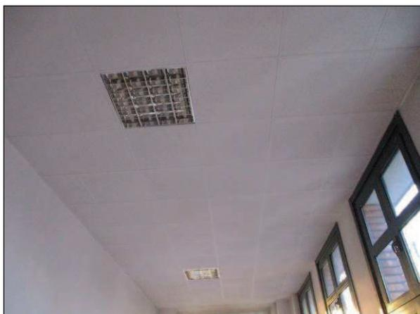
Foto n°1 - Visione d'insieme della Tipologia Controsoffitto n°1, realizzata con pannelli in fibra minerale ed installata nell'Aula 7 al piano primo.
