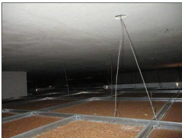
Foto n°6 - Particolare del sistema di pendinaggio, realizzato con elementi in fil di ferro fissati direttamente al sistema di alleggerimento del solaio sovrastante.
