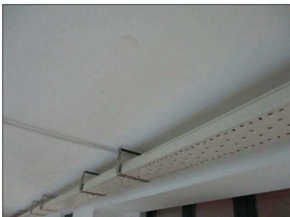
Foto n°17 - Porzione del plafone del Corridoio 4 al piano rialzato connotata da un grado di aderenza pessimo della finitura.
