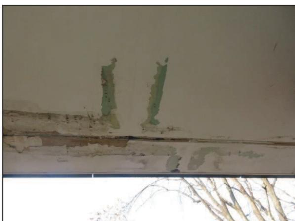
Foto n°11 - Vista di una porzione di controsoffitto in cartongesso degradata a causa delle infiltrazioni.
