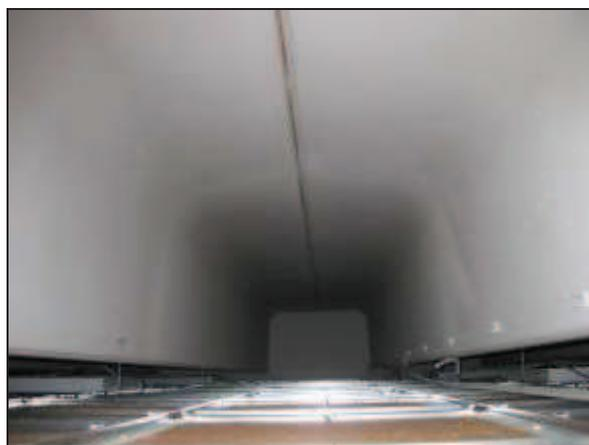
Foto n° 3-4 – Visione d'insieme del controsoffitto in sughero e del sistema di pendinatura.
