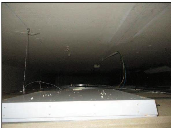
Foto n°2 - Individuazione del sistema di pendinaggio, realizzato con pendini di fattura artigianale in fil di ferro.
