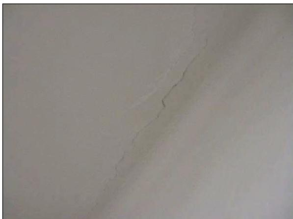
Foto n°13 - Porzione del plafone dell'Aula 8 al primo piano connotata da un eccessivo distacco della finitura.
