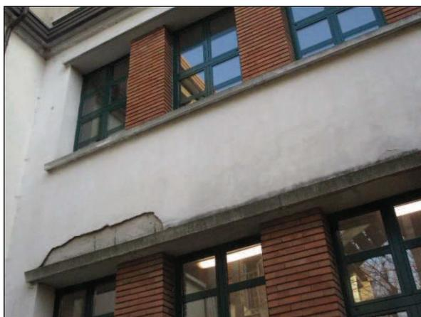
Foto n°28 - Porzione del rivestimento ampiamente distaccata, individuata sul fronte Nord a livello del Ripostiglio 4 al piano rialzato.
