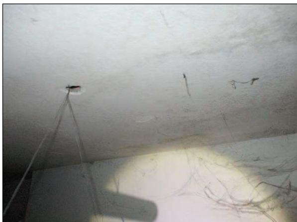
Foto n°19 - Porzione dell'intradosso del solaio della Mensa al piano rialzato connotata da una condizione pericolosa.
