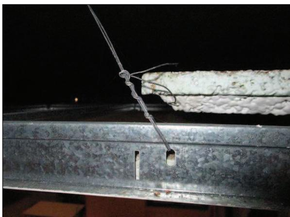
Foto n°7 - Particolare dell'ancoraggio della struttura di supporto dei pannelli al pendino.
