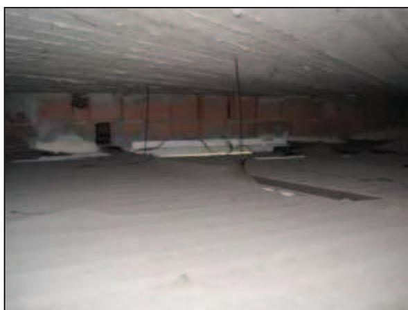
Foto n° 1-2 – Visione d'insieme del controsoffitto in doghe e del sistema di pendinatura.
