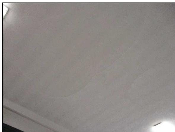
Foto n°14 - Porzione del plafone del Corridoio 5 al piano rialzato connotata da un eccessivo distacco della finitura.
