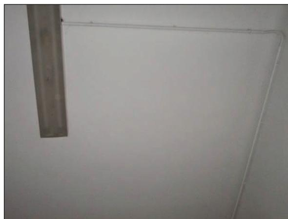
Foto n°16 - Porzione del plafone dell'Aula 3 al primo piano connotata da un grado di aderenza pessimo della finitura.
