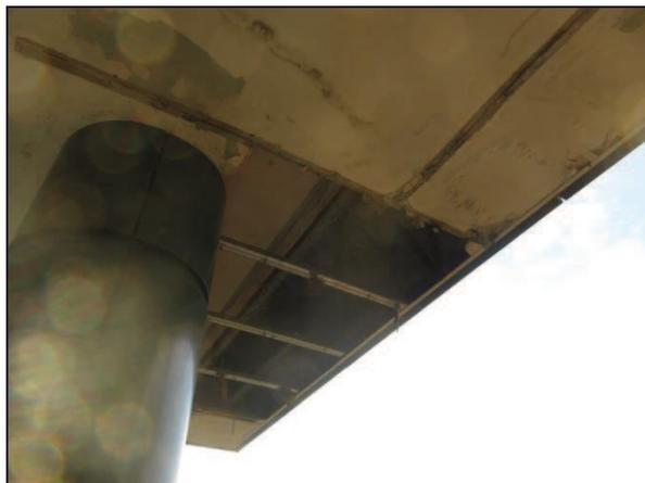
Foto n°10 - Vista di una porzione di controsoffitto in cartongesso mancante a causa delle infiltrazioni.
