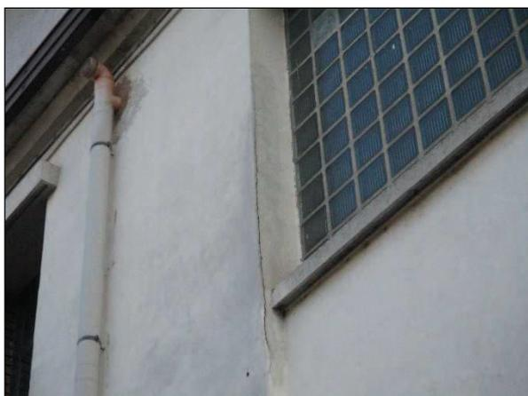
Foto n°27 - Porzione del rivestimento ampiamente distaccata, individuata sul fronte Nord a livello del Corridoio 1 al primo piano.
