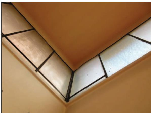
Foto n°2 - Porzione della finitura intonacata della Palestra al piano rialzato connotata da una condizione di conservazione pessima.
