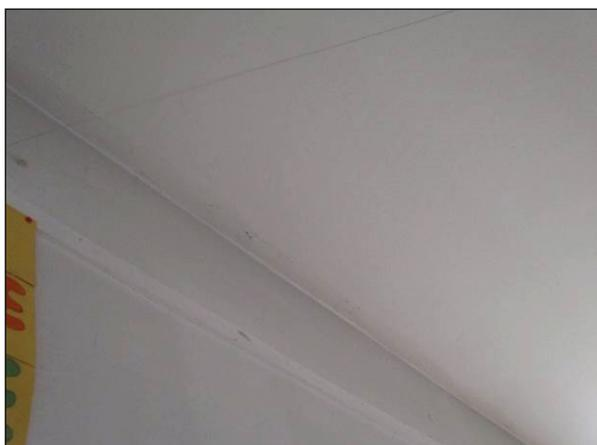
Foto n°21 - Porzione dell'intradosso del solaio dell'Aula 6 al secondo piano connotata da una conservazione pessima.
