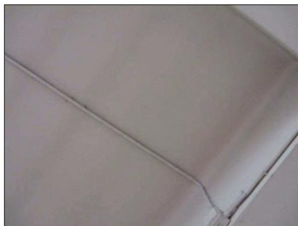
Foto n°18 - Porzione del plafone della Palestra al piano rialzato connotata da un grado di aderenza pessimo della finitura.
