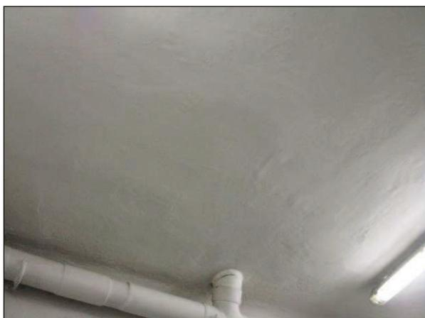
Foto n°15 - Porzione del plafone del Bagno 4 al primo piano connotata da un grado di aderenza pessimo della finitura.
