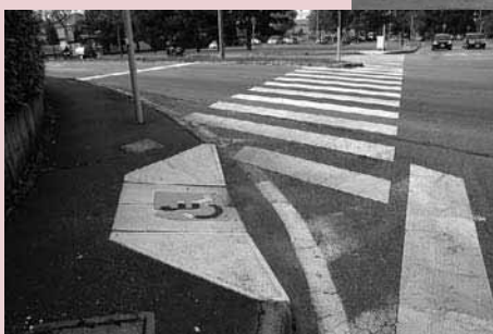
DUGNANO rampe per disabili
