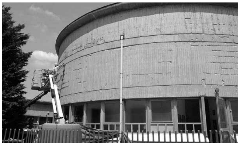
Rifacimento facciata Scuola Mazzini
