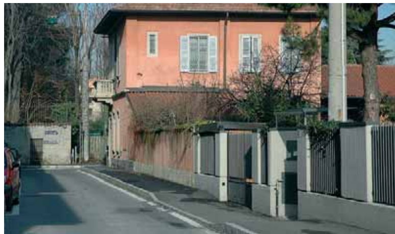
Marciapiede via Gorizia
