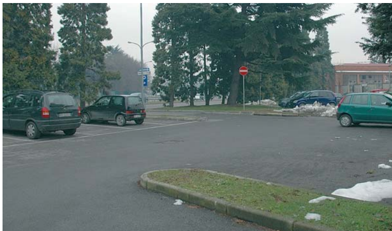
Parcheggio cimitero Paderno
