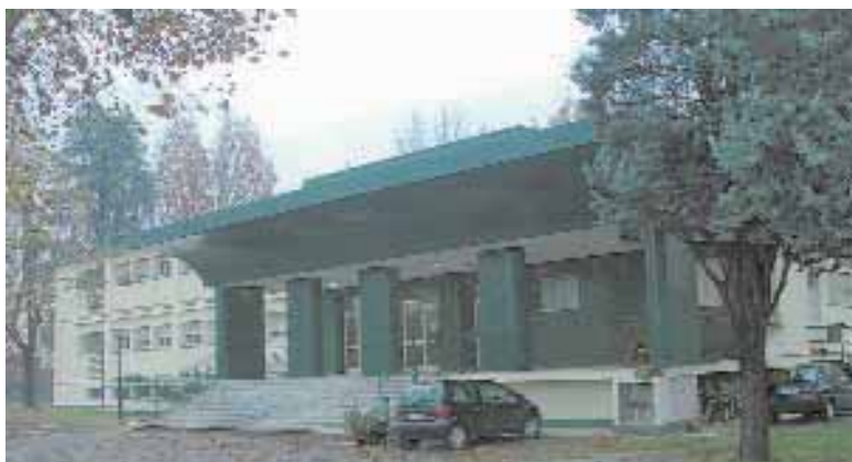
Ingresso e facciate Scuola Elementare Villaggio
