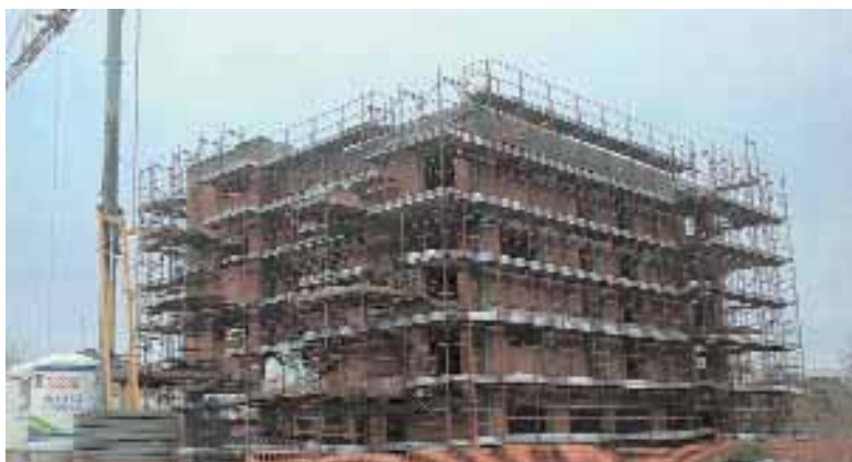
Cantiere del nido via Leopardi
