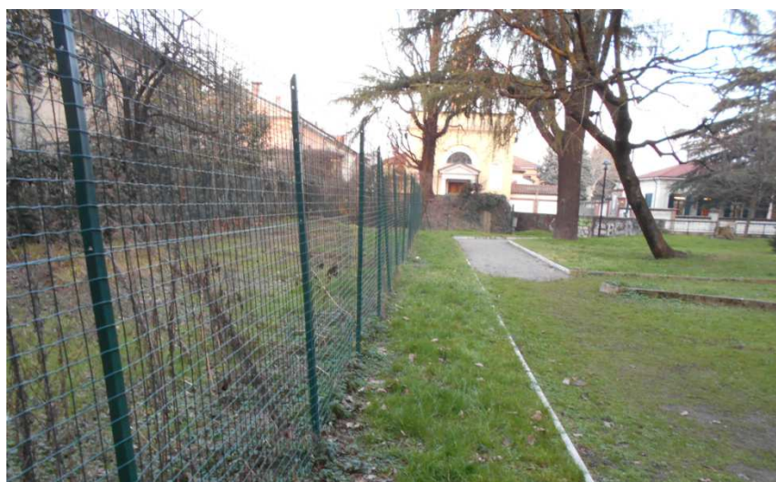
Foto 1: Recinzione esistente da rimuovere
