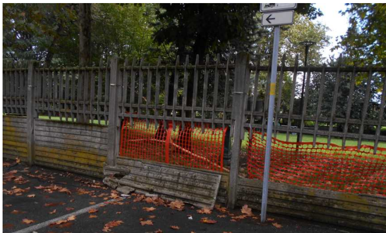
Foto 1: Recinzione da demolire
