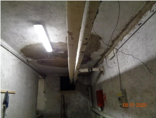
Foto 6: Dorsale impianto riscaldamento - ala sud
