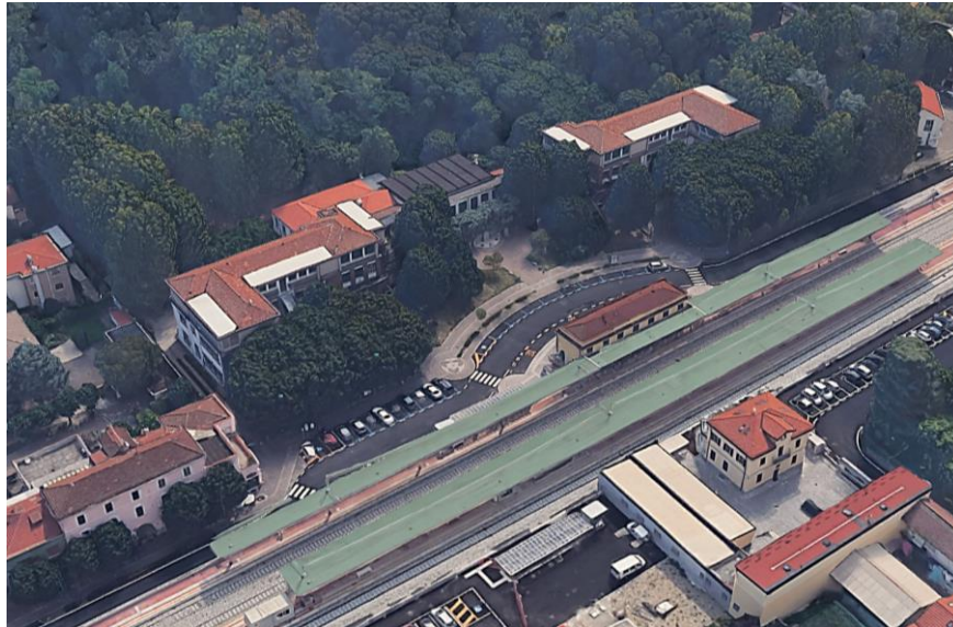
Foto 1: Veduta d'insieme edificio scolastico
