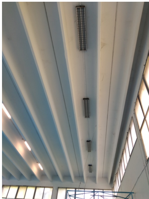
Palestra scuola elementare "Manzoni" via Corridori n.24 neon da 2x58 watt
