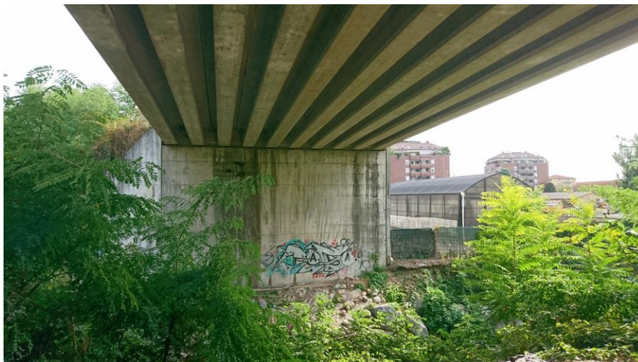
Figura 9: Spalla Lato Via Camposanto vista da pila centrale
