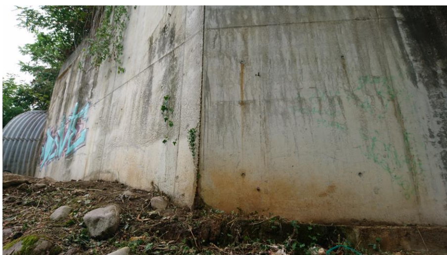
Figura 5; Spalla e muro andatore Lato Via Camposanto
