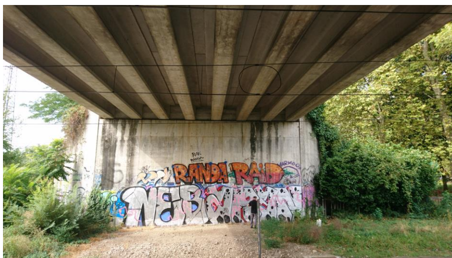
Figura 13: Spalla Lato Via Battisti
