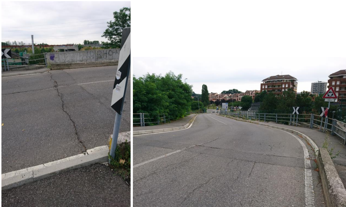
Figura 2: Rampa di accesso da Via Camposanto
