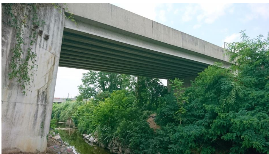
Figura 7: Impalcato lato Via Camposanto
