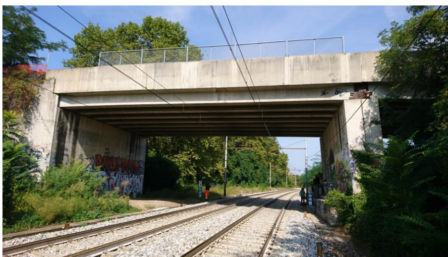
Figura 11: Impalcato Lato Via Battisti
