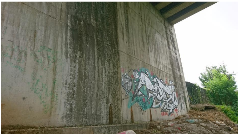
Figura 3: Spalla lato Via Camposanto
