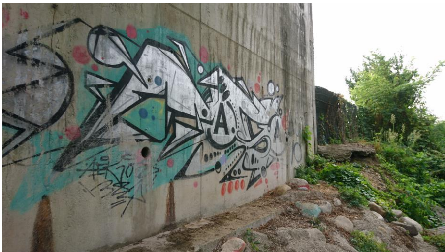
Figura 6: Spalla e fondazione Lato Via Camposanto
